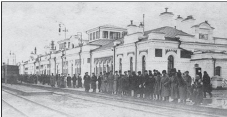
Станция Омск. Железнодорожный вокзал. 1906 г. Фототипия. Архив А. В. Колесова.
