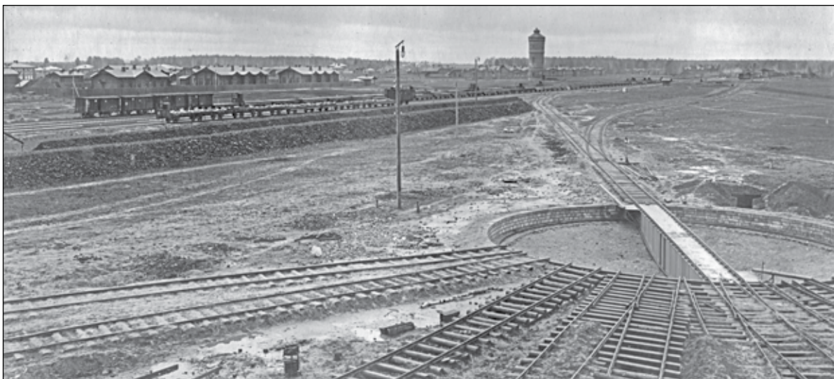
Станция Ишим. Общій вид с крыши паровозного депо. На переднем плане поворотный круг, с помощью которого разворачивали паровозы. Вокзал находится вдали справа. Ноябрь 1913 г. Фотография из альбома «Снимки сооружений Тюмень-Омской и Синарско-Шадринской ж.д.». Архив С. Р. Дубинского.
