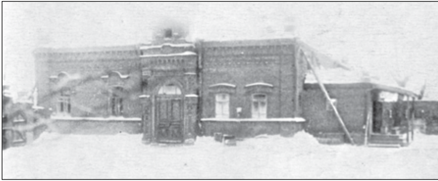
Дворовый (северный) фасад аптеки. Слева – утраченные впоследствии ворота, справа – снесённые в 1979 году кирпичные сени с крыльцом. 1953 г. Из архива Н. Г. Мусихиной.
