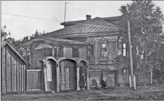
Село Покровское. Бывший дом Г. Е. Распутина. Снесён по распоряжению властей в 1980 году. 1960-е гг. МКиС.
