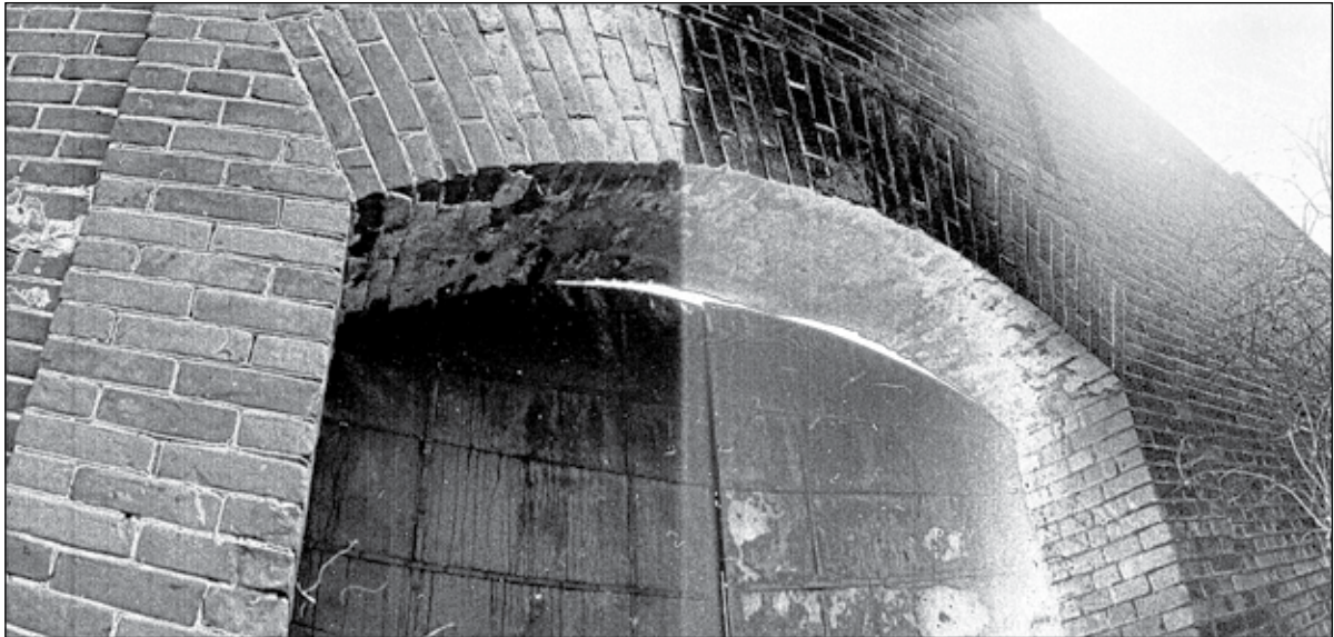
Внутренняя стена усадебной ограды и арка с воротами, ведущими на аптечный огород. (Утрачены.) 1970-е гг. Фотография С. А. Глухих.
