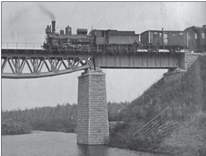
Мост через реку Солоновку на 169 версте между станциями Омутинская и Ламенская. 1913 г. Фотография из альбома «Снимки сооружений Тюмень-Омской и Синарско-Шадринской ж.д.». Архив С. Р. Дубинского.
