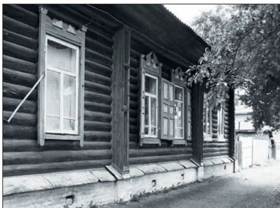
Дом № 36 на ул. им. Чайковского в Ишиме, где жила семья Плотниковых. Сентябрь 2009 г. Фотография Г.А.Крамора.
