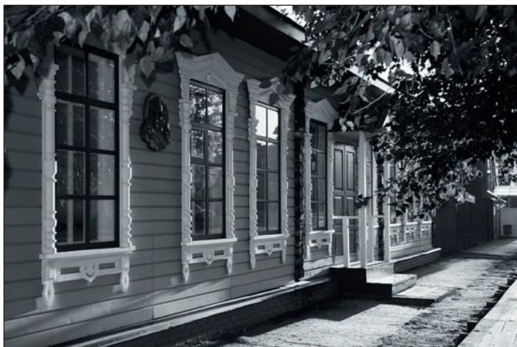
Обновлённый (после ремонта) фасад Культурного центра П.П.Ершова в г. Ишиме. Сентябрь 2009 г.
