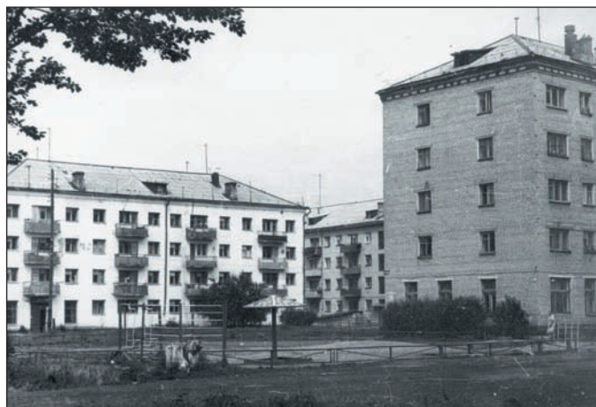
Дома, построенные на месте болота на углу улиц им. Маркса и Почтовой. Начало 1980-х гг. Фотография Н.П.Хрулёва.
