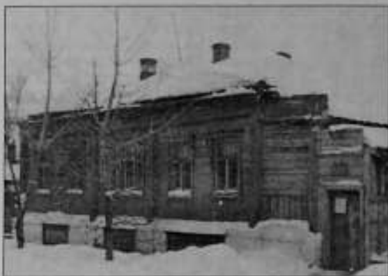
Дом на улице Чкалова (напротив типографии; снесён), где в числе семейных преподавателей ИГПИ жили Капины. Ишим. 1950-е.
