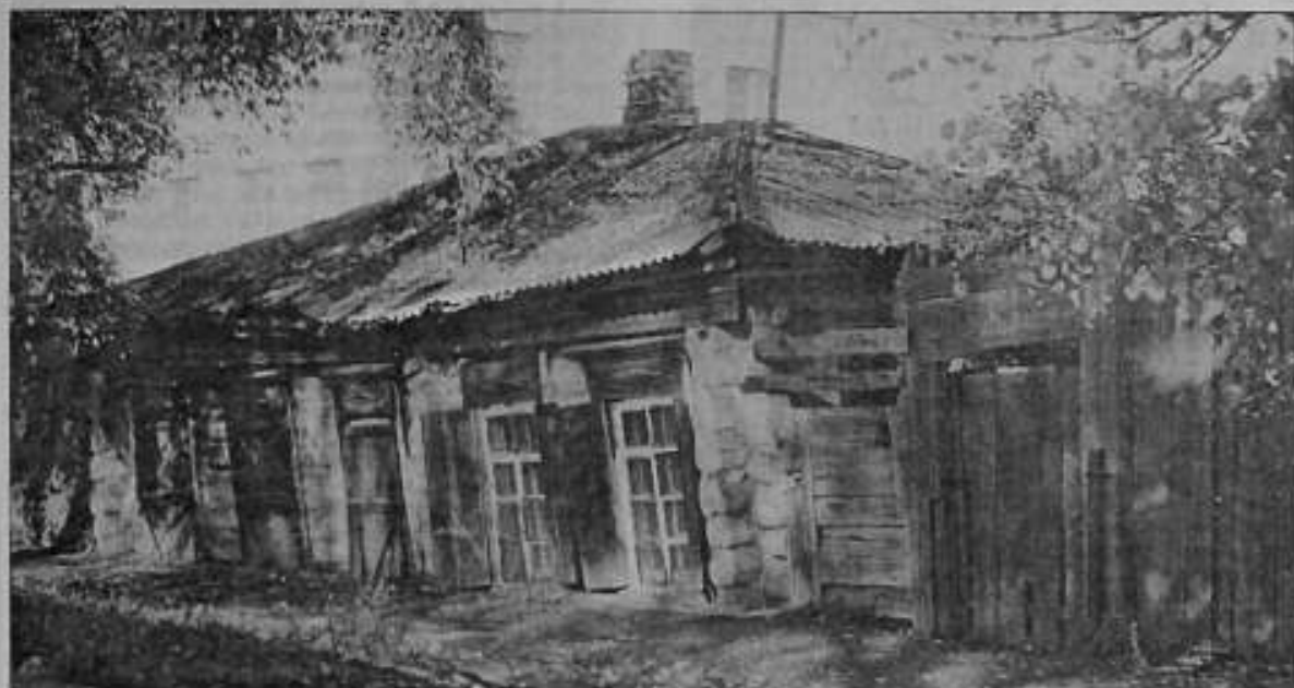
Дом Кожиных в Ишиме по ул. Ленина, 46 (снесён). Сентябрь 1996. Фотография Г.А.Крамора.
