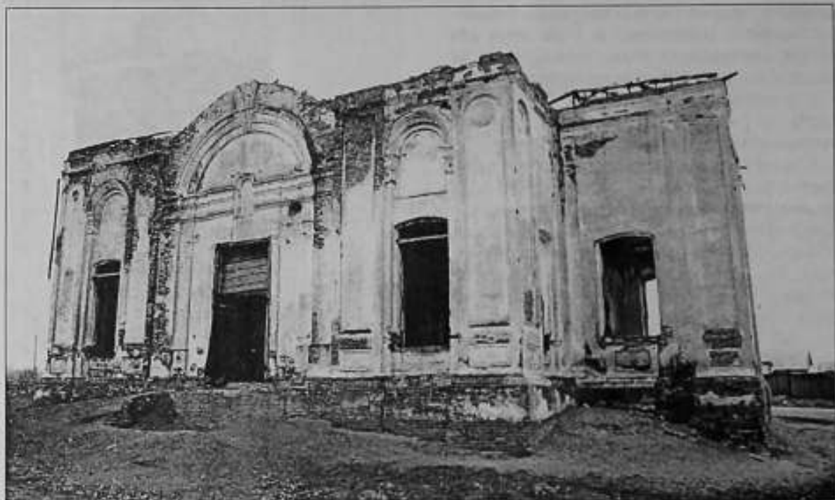
Христорождественская церковь в селе Афонькино. Вид с севера. Октябрь 2003. Фото Г.А.Крамора.
