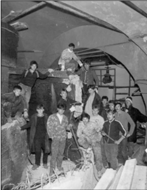
*Демонтаж железобетонных отстойников на 1 этаже собора. 1990 год. Фотография В.В.Ипполитова. ИИХМ.*
