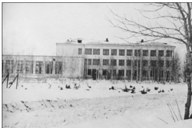
Новопостроенное здание школы № 7. Вид со стороны роцци. Начало 1970-х гг. Фотография. Музей школы № 7.
