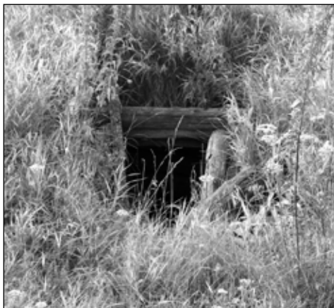
Завалившийся Ивановский колодец.
