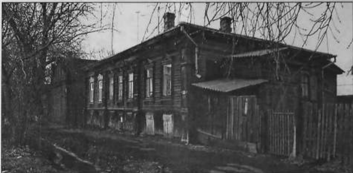
Дом, где жили Калугины на бывшей Больше-Никольской улице. Ишим, ул. Ленина, 23. Апрель 2004. Фото Г.А. Крамора.
