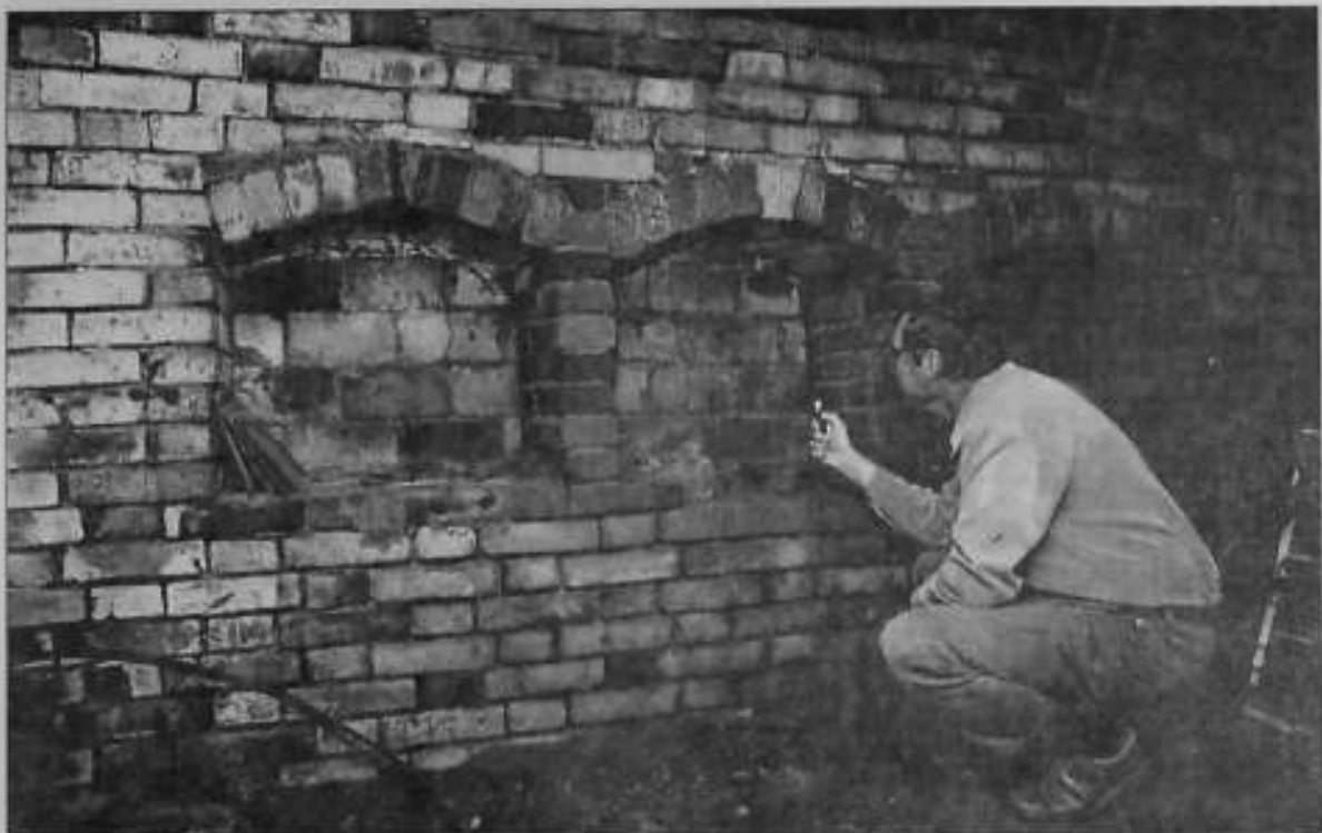
Тройная ниша в поперечной стене подвала здания наркодиспансера (быв. дом Кутырёва). Июль 2006.
