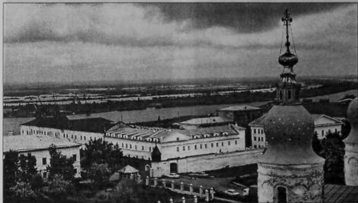
Вид на тюремные корпуса с Софийской колокольни.
