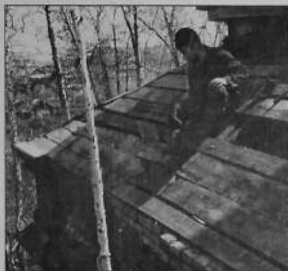
Игумен Евтихий на ремонте крыши Екатерининского храма. Шаблыкино, Ишимский район. Нач. 1990-х. Фото П.Д. Земляных. Из архива автора.
