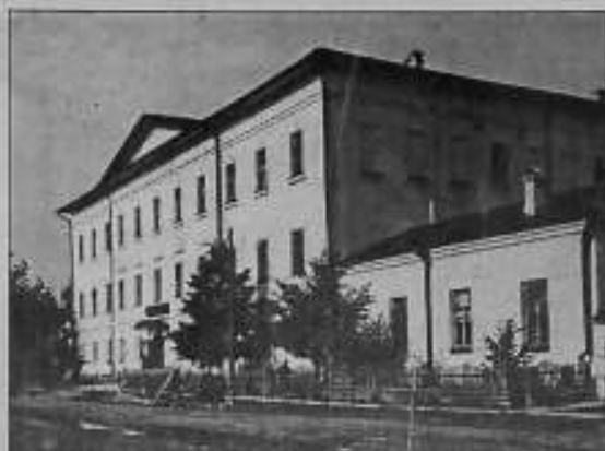
Главный корпус Тобольской больницы. Кон. 1950-х. Архив ЛМЕ.
